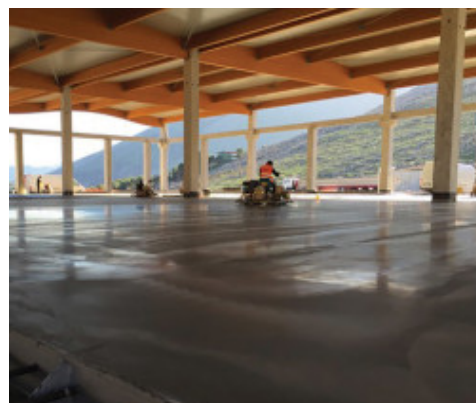
Példa Mapefibre ST 50 Twisted szálakkal erősített ipari padlóra
